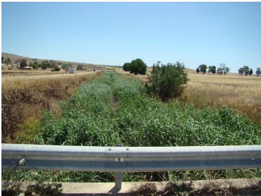
Fig. 2/7: Tratto a valle della S.P. 41
