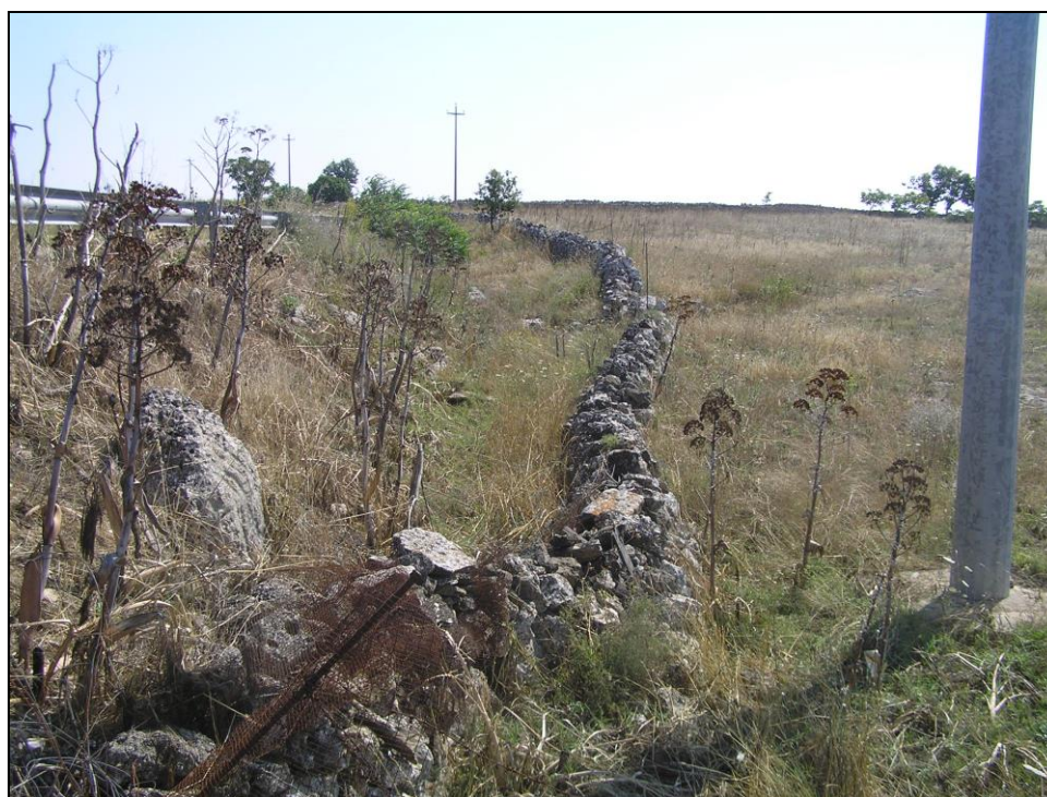
Fig. 4 _Ingombro della via ricalcata dalla 106.
