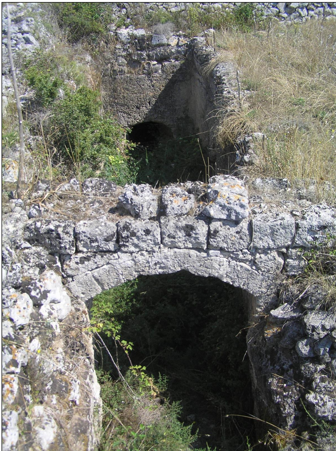
Fig. 13 _Arco in conci al di sopra della rampa d'ingresso agli ipogei e apertura d'ingresso sul fondo.
