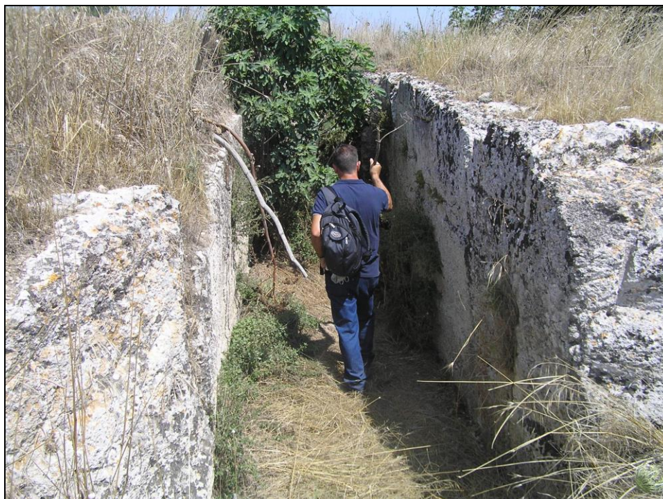
Fig. 43 _Rampa di accesso alle cavità aperte lungo le pendici nord-orientali dell'altura di Masseria Losurdo.
