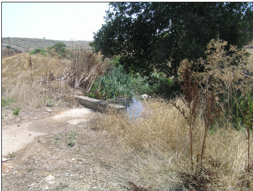
Fig. 55 Attraversamento n. 2 visto da sud.
