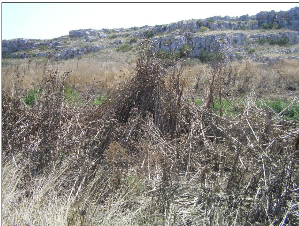
Fig. 30_ Sponda destra del canale Jesce nel settore centrale dell'UT 2 vista da ovest, a nord-occidente di Masseria Losurdo.
