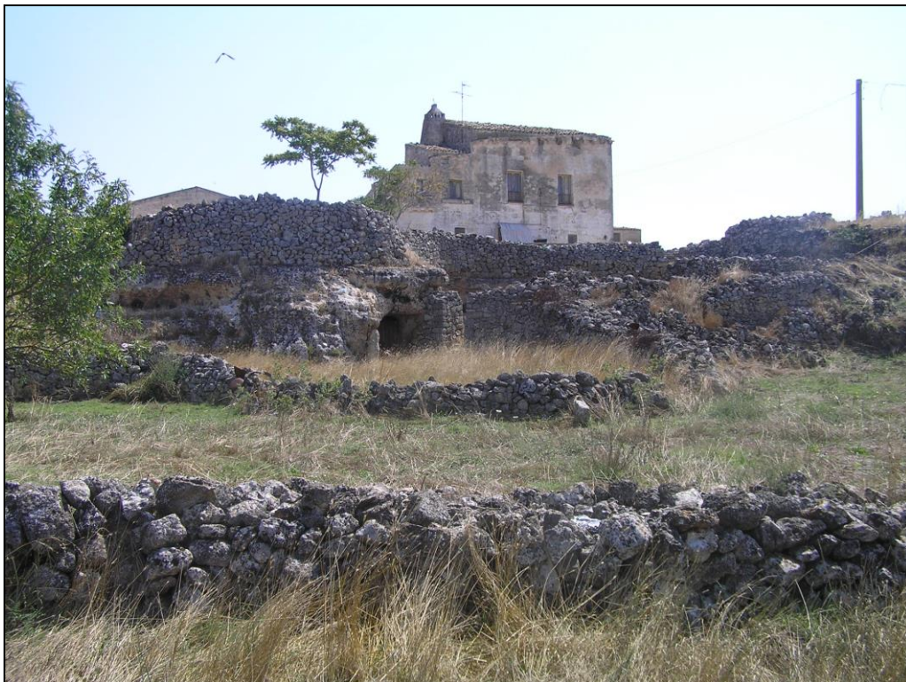
Fig. 20_ Sponda sinistra del canale Jesce. Cavità ricavate nel banco roccioso.
