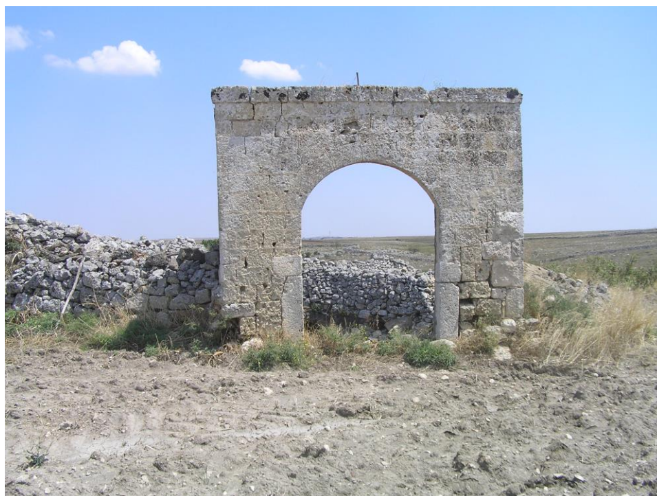
Fig. 46 _Ingresso monumentale ad un'altra apertura d'ingresso ai vani ipogei presenti lungo le propaggini nord-orientali dell'altura di Masseria Losurdo.
