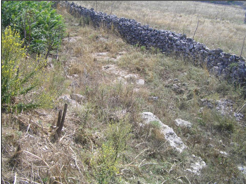
Fig. 5 _Resti della sede stradale.
