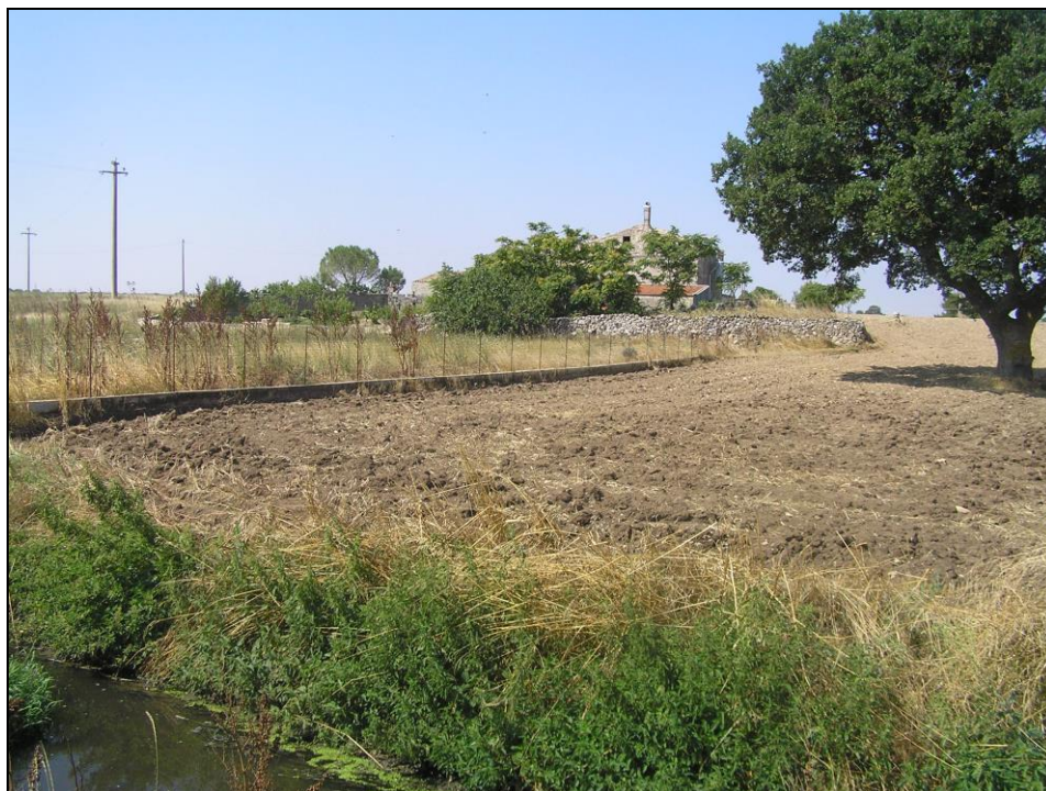
Fig. 7_ Sponda destra del canale Jesce a est del ponte della 106 vista da ovest.
