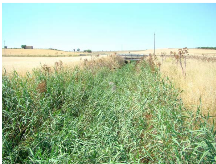
Fig. 2/3: Canale Jesce nel tratto a valle del punto di scarico e prima della Masseria De Mari
