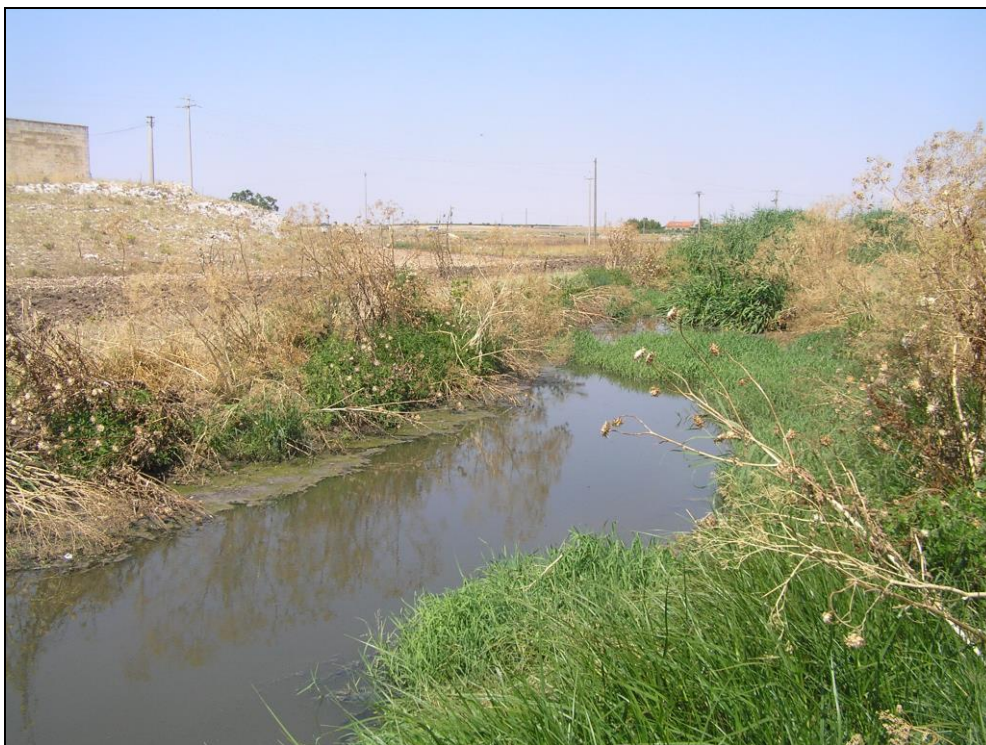
Fig. 24_ Sviluppo del canale Jesce in prossimità di Lamione Carpentino visto da est.
