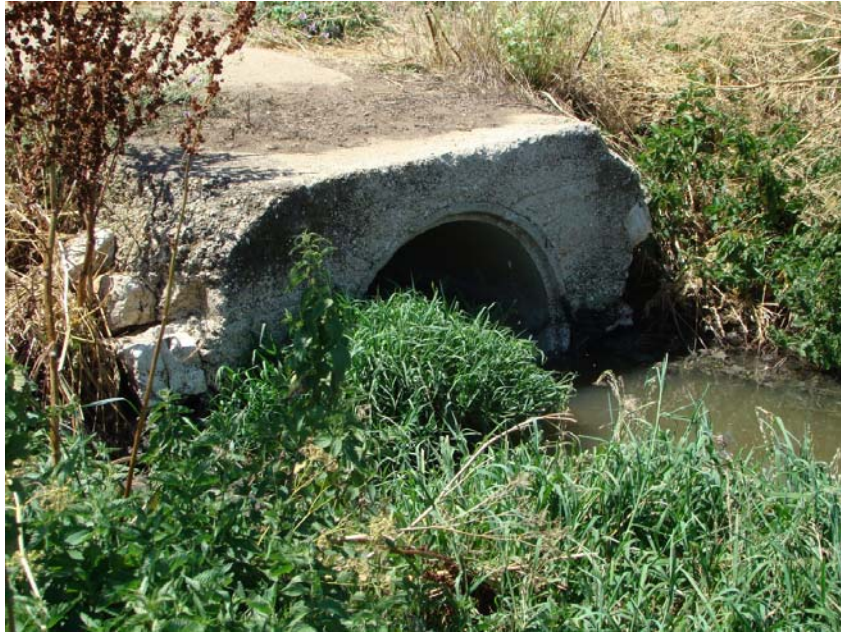
Fig. 2/6: Attraversamento di una strada vicinale sul Canale Jesce
