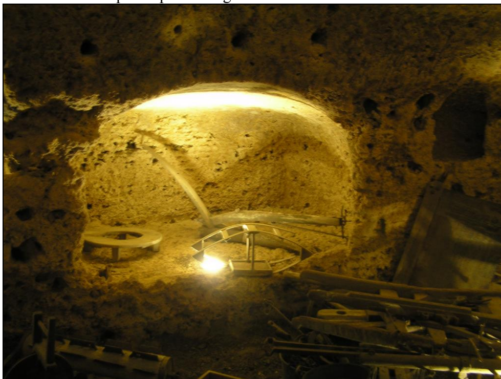
Fig. 54 _Cavità al di sotto dell'edificio di Masseria Losurdo.
