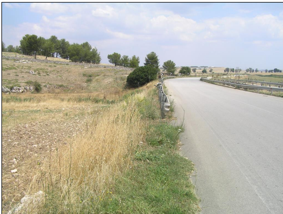
Fig. 83 Attraversamento della SP 41 del canale Jesce.
