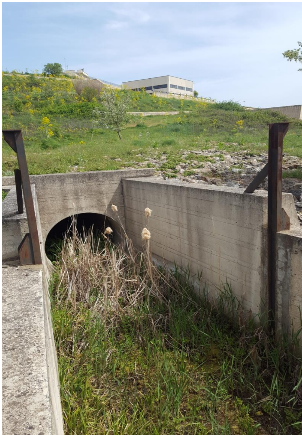
Manufatto di imbocco della derivazione
