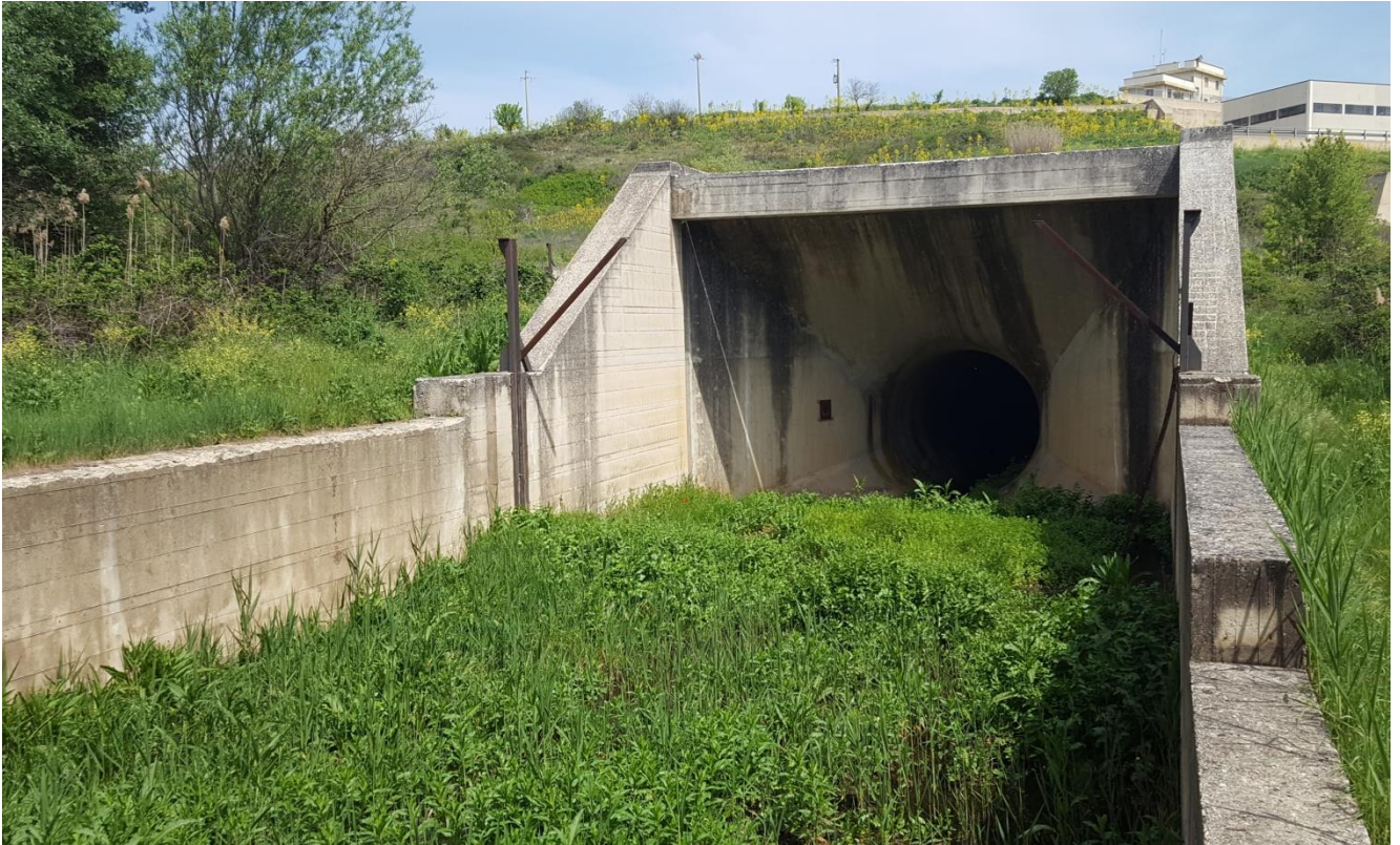
Manufatto di imbocco dello scarico di fondo
