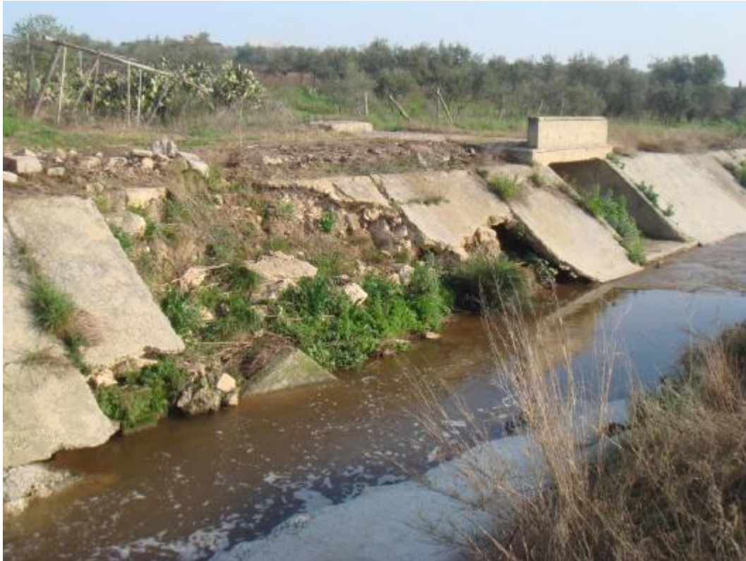
Foto n.1. In corrispondenza del canale Ciappetta
