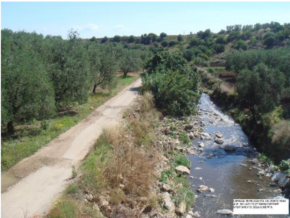
Vista del canale con evidenza dell'erosione di sponda e della vegetazione invasiva
