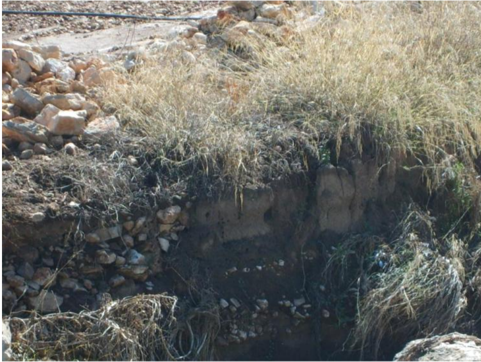
Particolare dell'erosione di sponda nei depositi alluvionali
