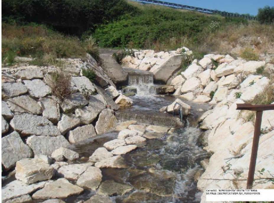
Vista da valle del tratto già rivestito subito a valle del rilevato dell'autostrada A14
