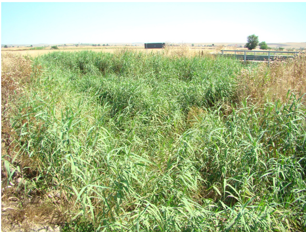
Foto 5 – Tratto del canale Jesce con sezione risagomata
