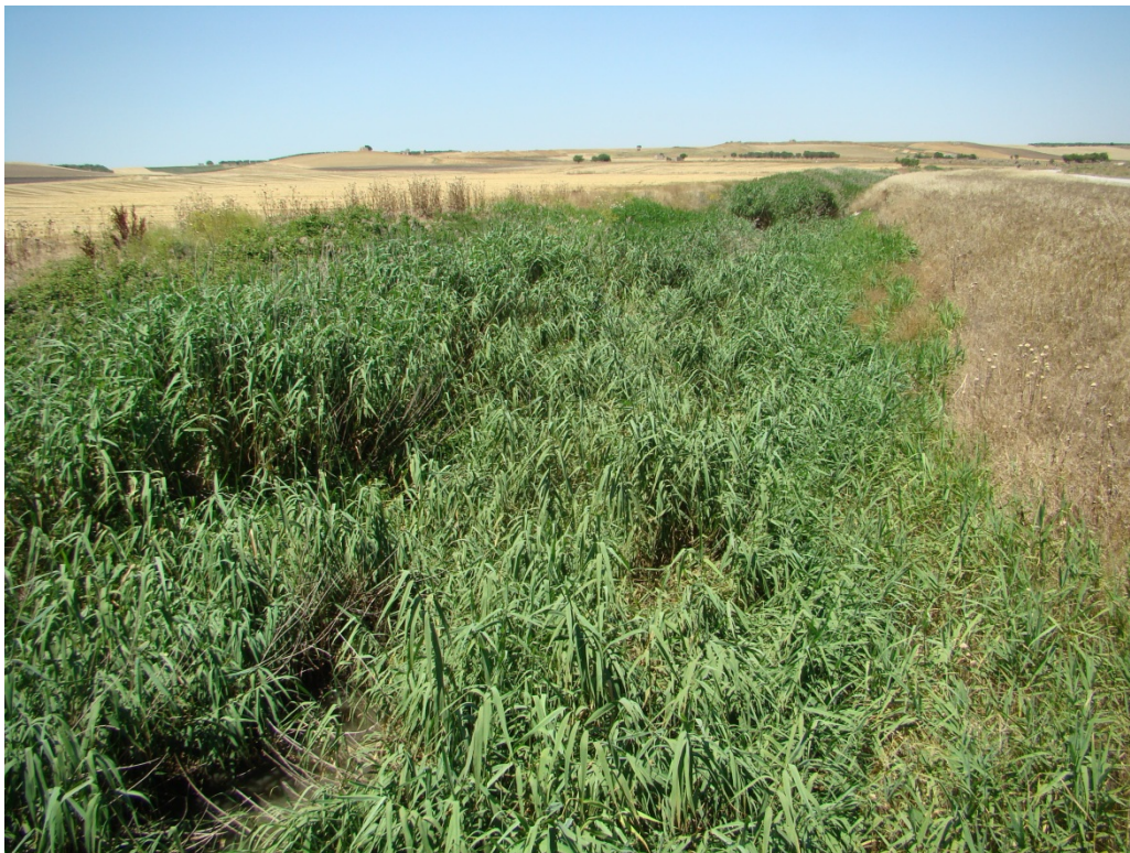
Foto 23 – Tratto del canale Jesce con sezione risagomata
