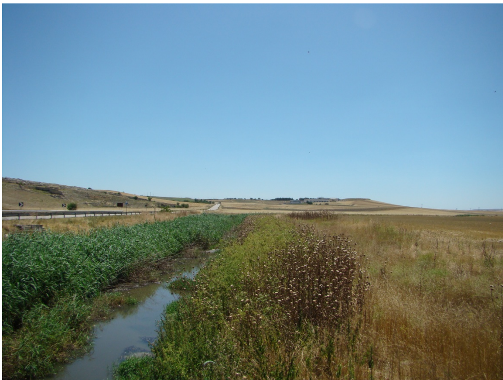
Foto 24 – Tratto del canale Jesce con sezione risagomata
