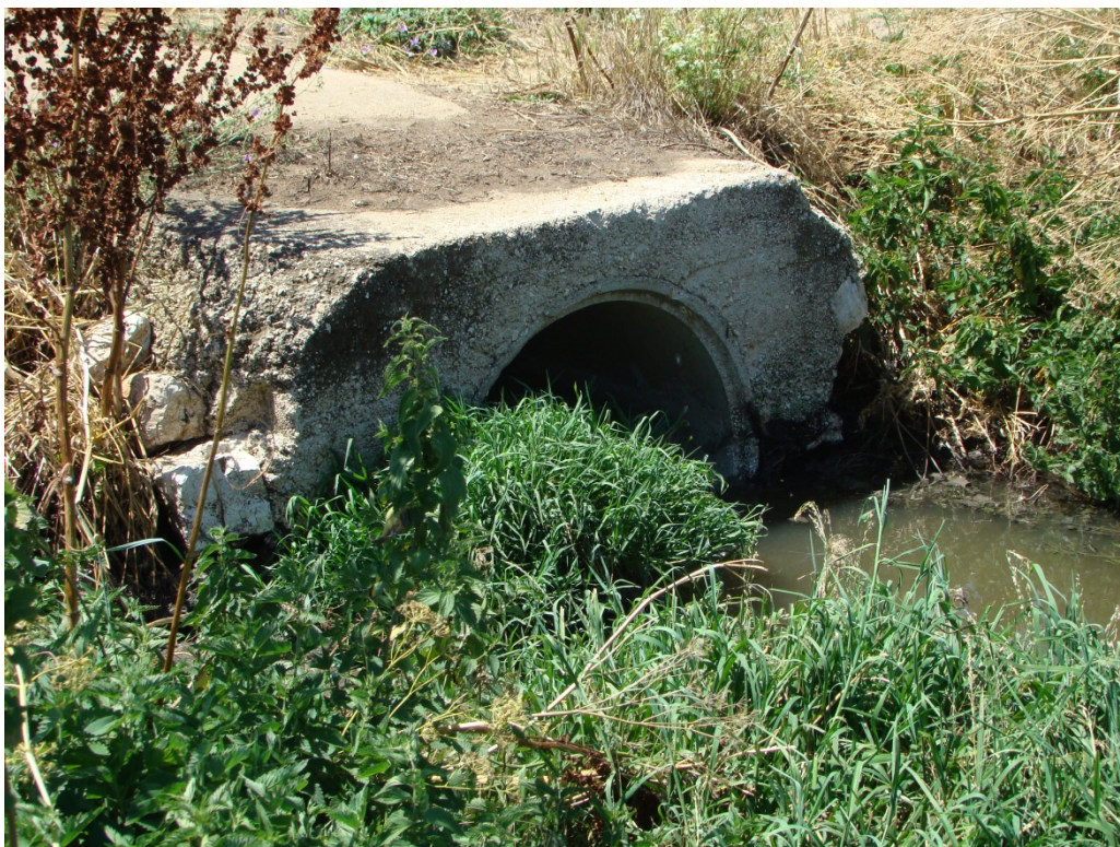
Foto 12 – Tratto del canale Jesce con sezione non risagomata – attraversamento poderale
