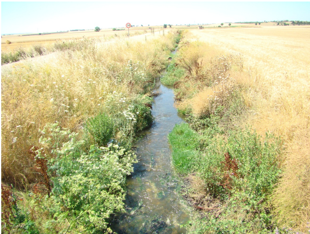
Foto 3 – Tratto del canale Jesce con sezione risagomata
