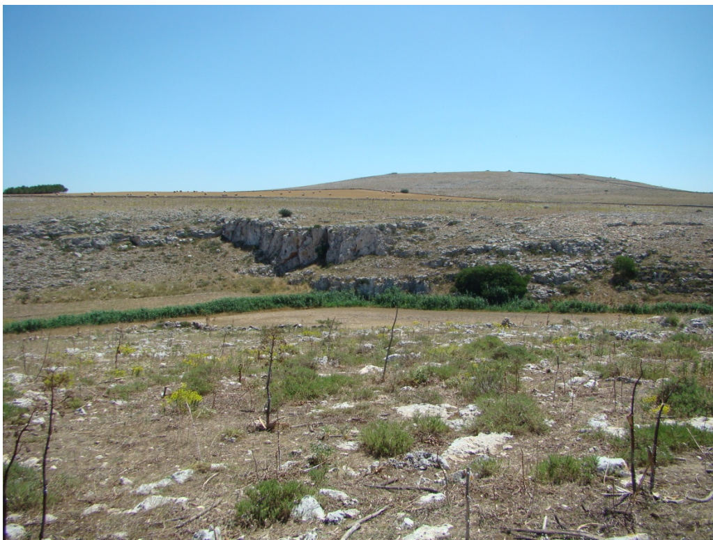
Foto 20 – Tratto del canale Jesce con sezione non risagomata
