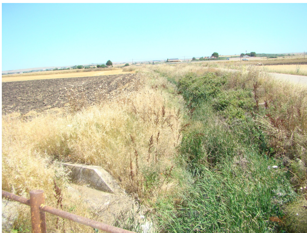
Foto 2 – Tratto del canale Jesce con sezione risagomata
