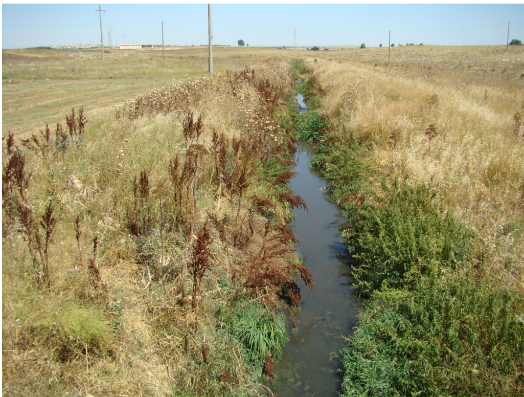
Foto 9 – Tratto del canale Jesce con sezione risagomata
