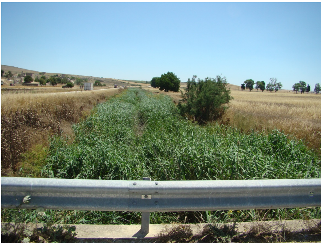
Foto 22 – Tratto del canale Jesce con sezione risagomata
