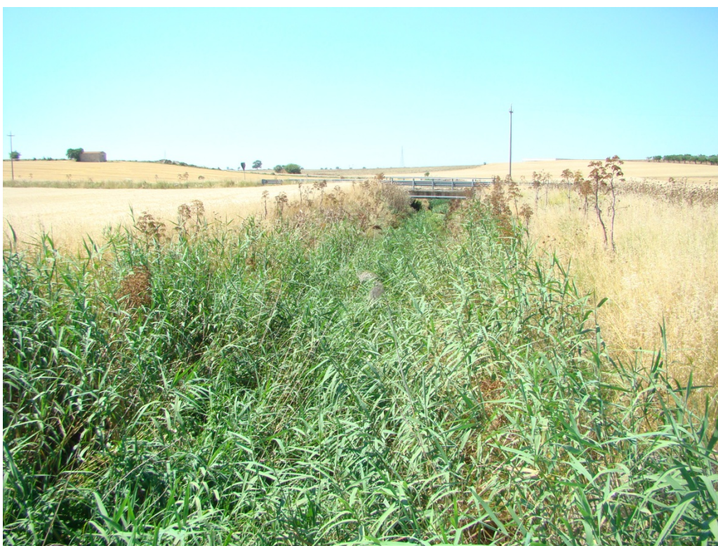
Foto 6 – Tratto del canale Jesce con sezione risagomata
