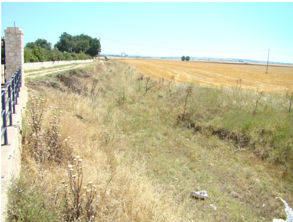
Foto 8 – Tratto del canale Jesce con sezione risagomata
