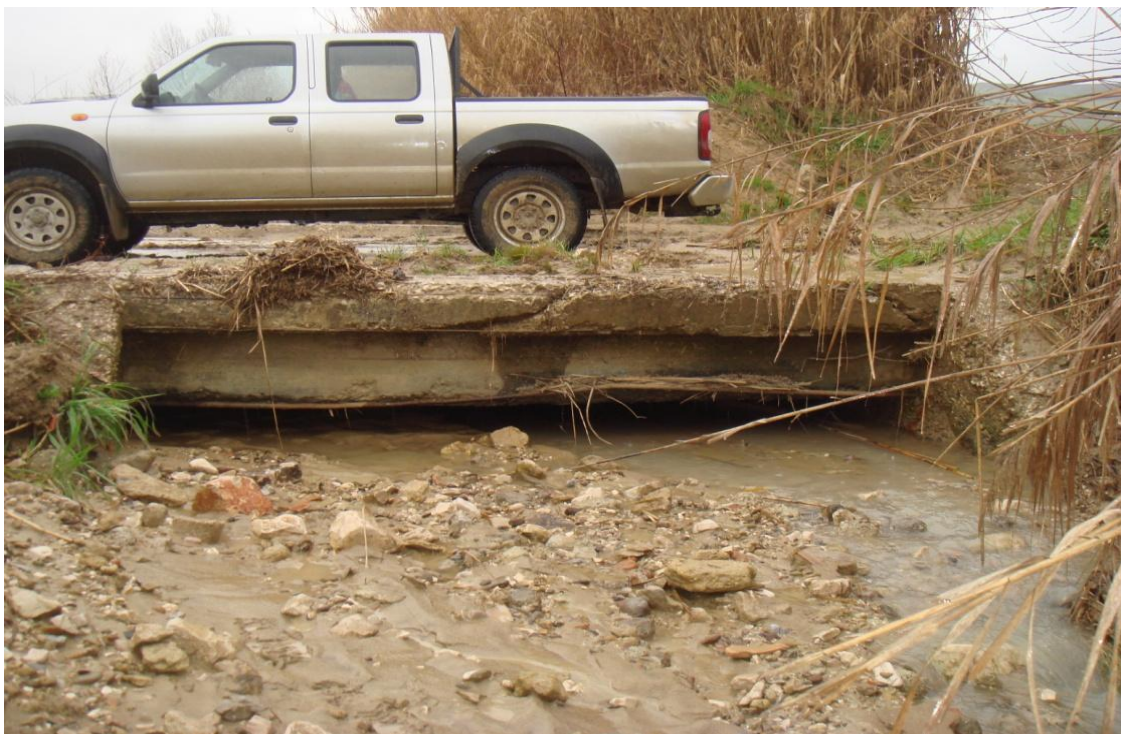
Foto n° 1. Ponte sul canale Giaurro di attraversamento della ex s.p. n° 5
