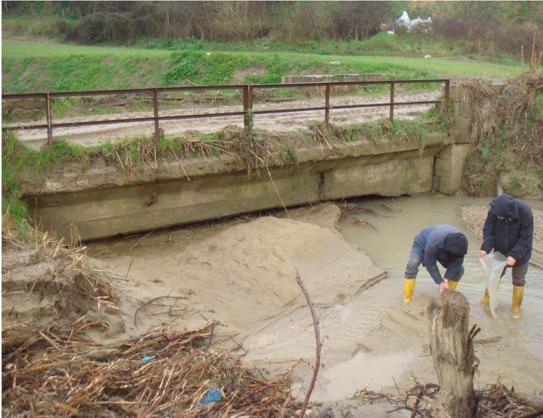
Foto n° 2. Ponte sul torrente Locone su strada vicinale Chiancarella
