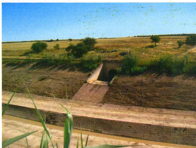
Foto 2 – Tombino di scarico a fine dei lavori in corso
