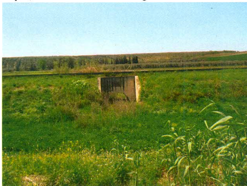
Foto 1 – Tombino di scarico, l'interrimento è al di sopra del livello di scarico
