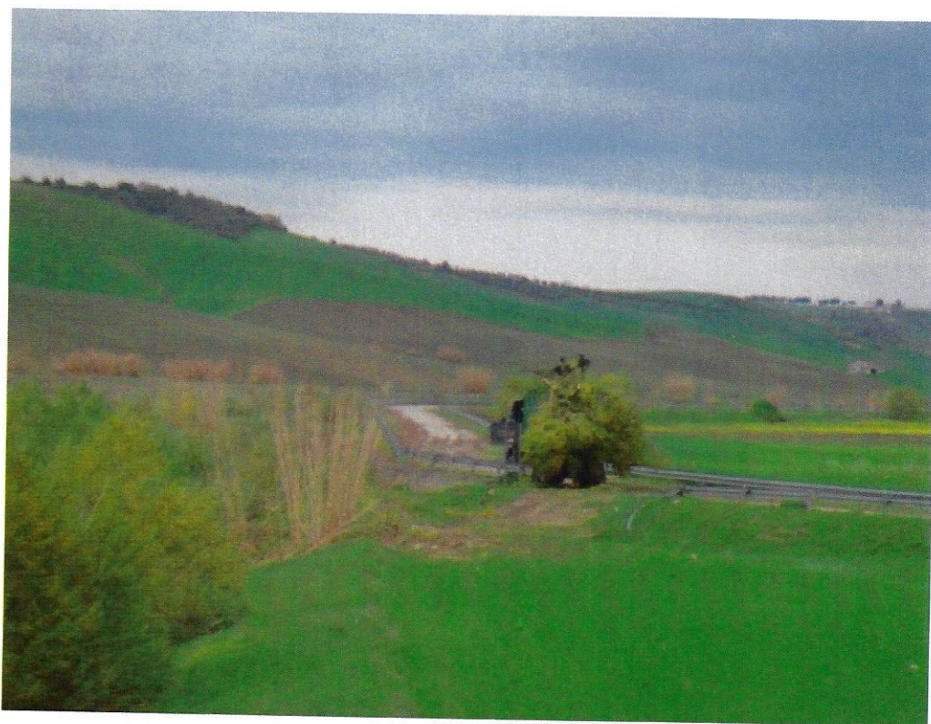
Foto scattata dal ponte sulla s.p. n° 230 Spinazzola – Minervino nel corso dei lavori
