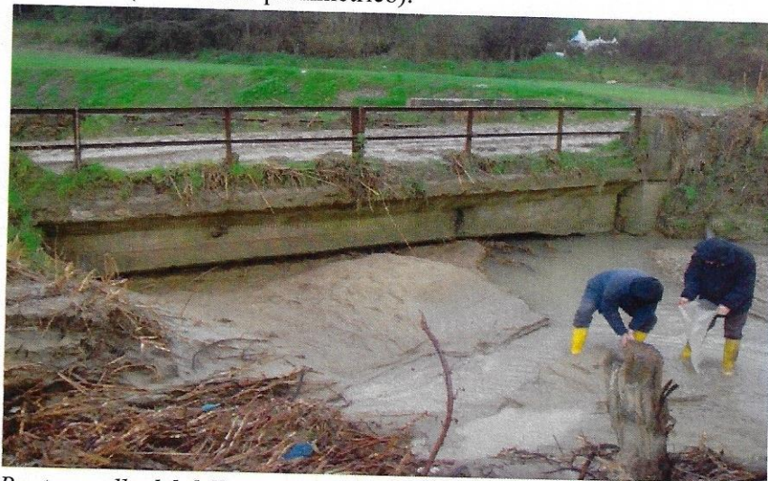
Ponte a valle del della s.c. Carrozza, prima dell'intervento (cfr planimetria)
