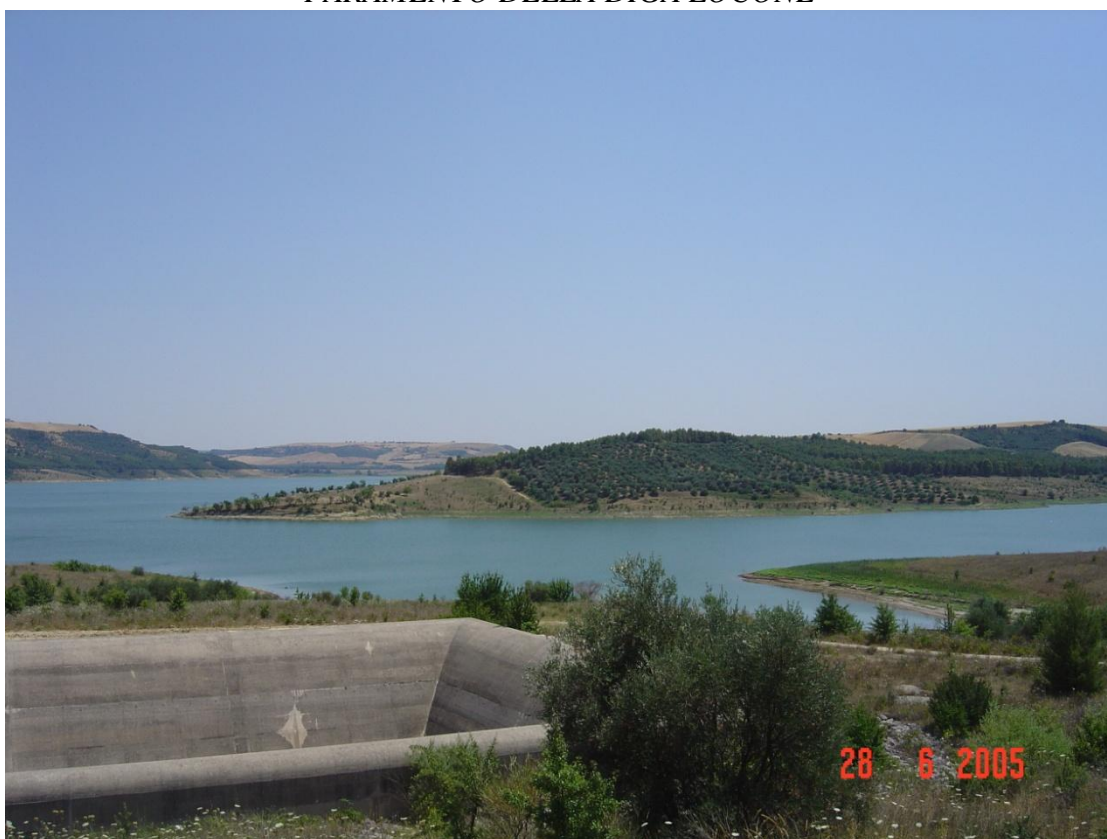
PARTICOLARE DIGA LOCONE
