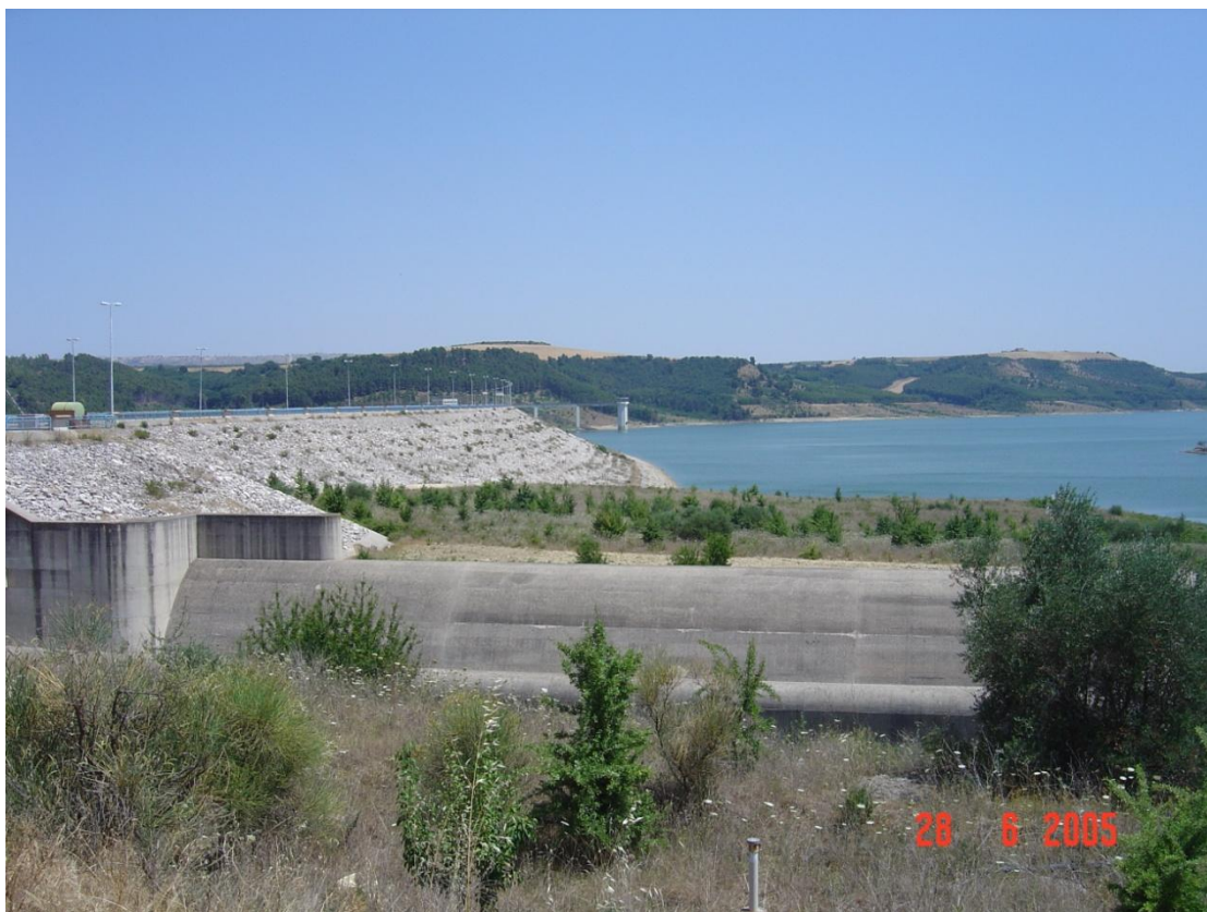
PARAMENTO DELLA DIGA LOCONE
